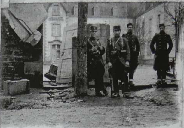
PLOËRMEL — Expulsion des Frères — Portail du Pensionnat après l'entrée de Surty
