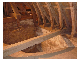
Choeur - Détail du versant nord © 2011 - BERNARD, Vincent
