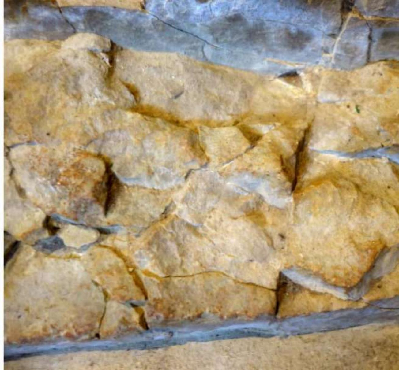
Abbaye de Paimpont – *Salle des Ecrouettes* : Fondations de l'Abbaye découvrant des bancs quartzitiques (Grès armoricain).
