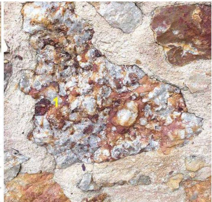
Abbaye de Paimpont : Conglomérat Briovérien (*poudingue de Gourin*) avec fissure (F) filon de quartz (Q) et galets noir de phanite (1).
