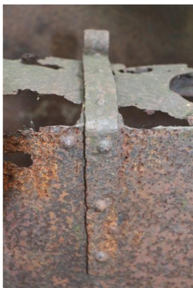
Absente sur le four du Hindré, la face supérieure rabattable tourne autour des gonds et vient se poser sur une barre en équerre qui est tout autour du four (voir photos). Une poignée (ou 2) sont indispensables. Elle s'appuie sur l'intérieur du four et non en débordement. Ceci doit permettre d'étanchéifier (avec de la terre) le four pour l'extinction...
