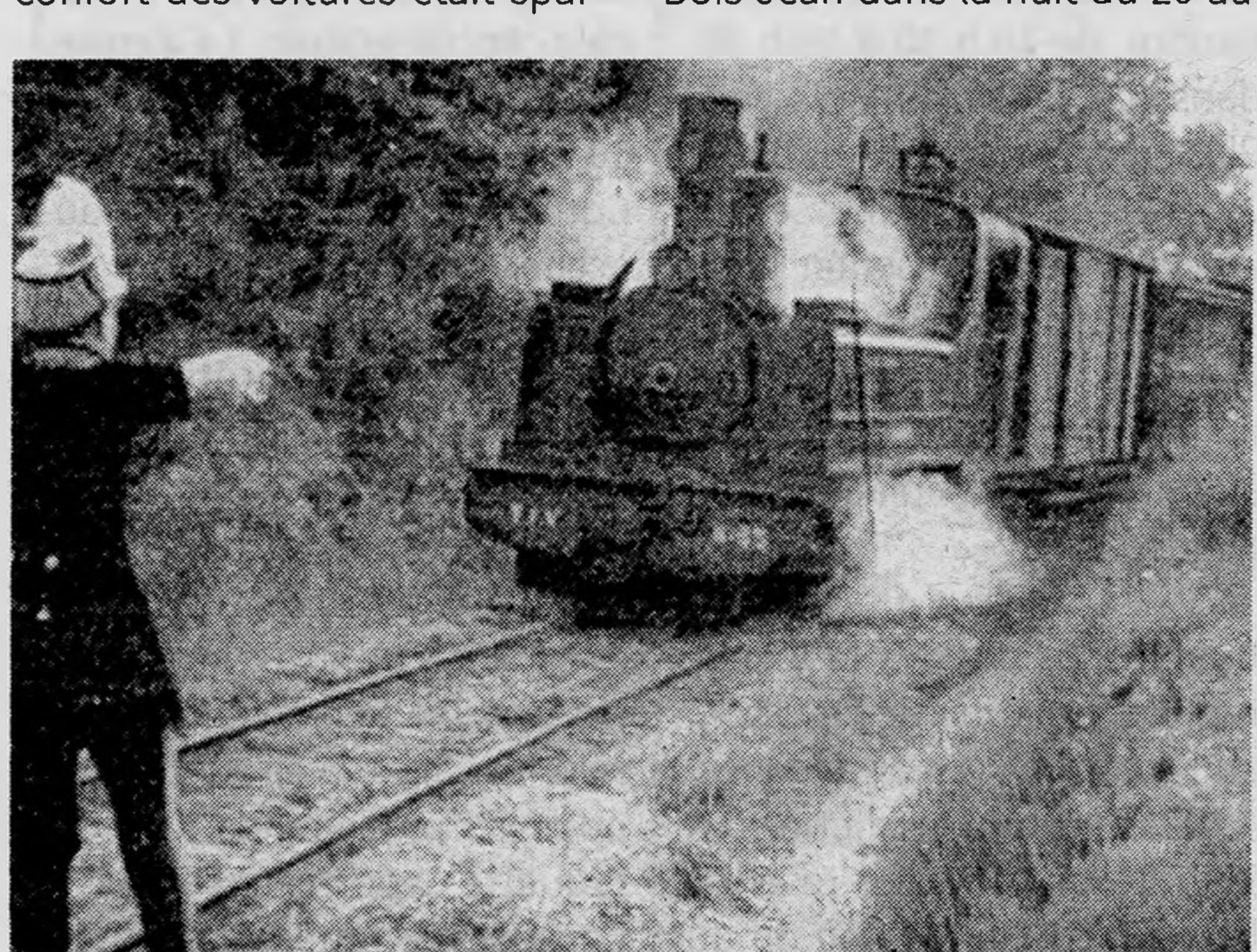
Colonel des Gardes G. BÉCHU, arrête le TIV dans la tranchée.
