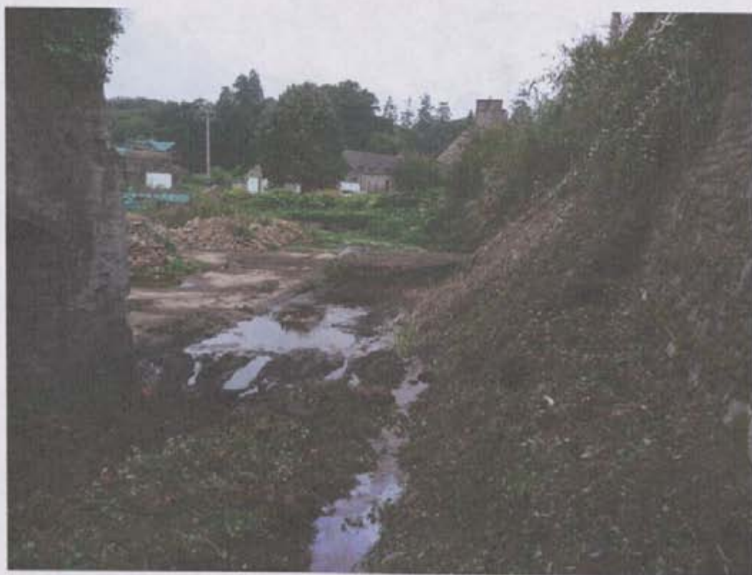
Figure 2 : Photographie de la zone d'intervention avant nettoyage des structures.
