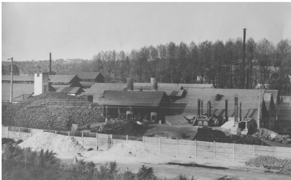
Figure 43. Extérieurs de l'usine, côté ouest. Les deux cheminées des cubilots se devinent au centre, avec le tas de coke stocké en extérieur. Source : Archives Départementales des Ardennes. 73J1592
