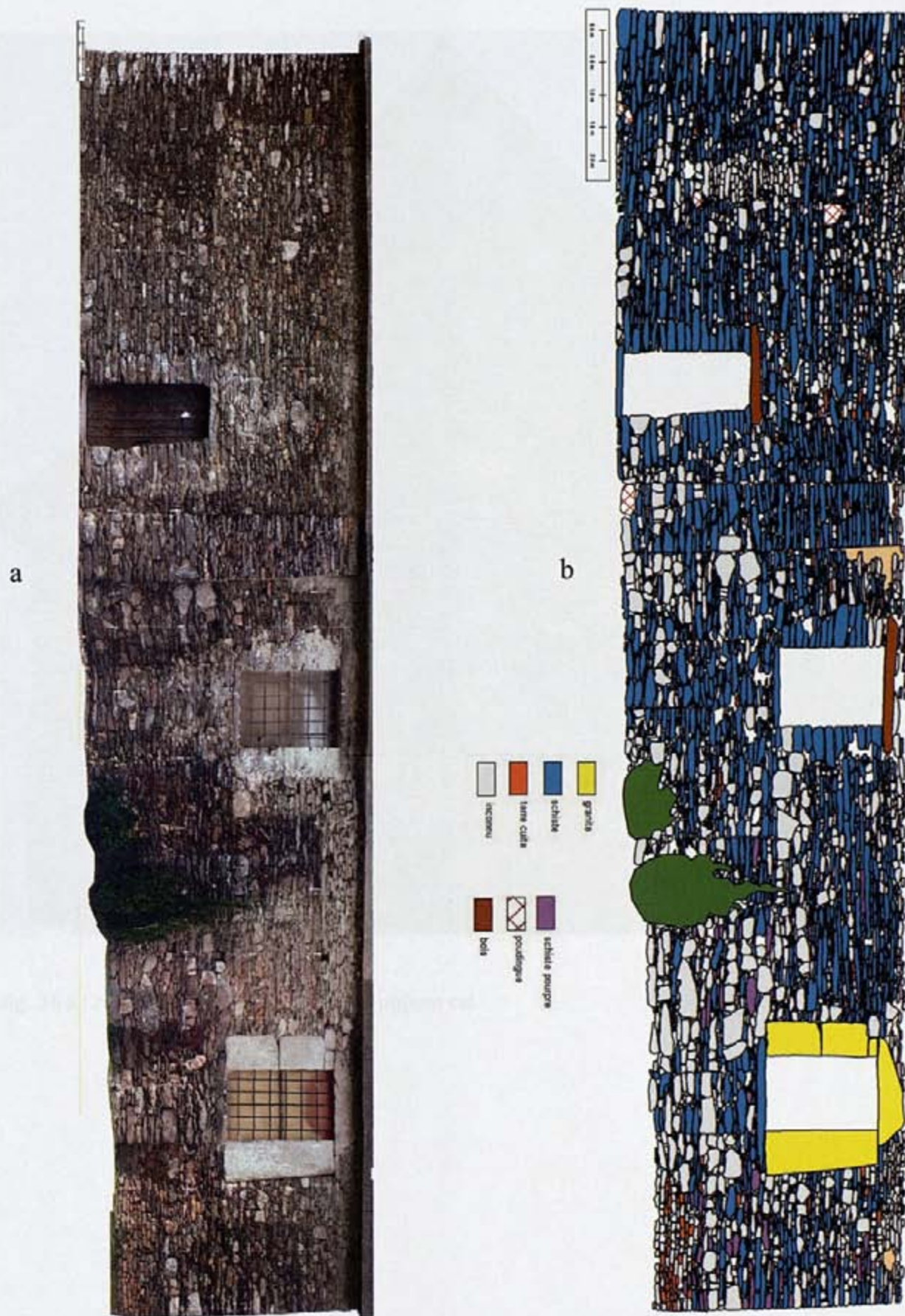
fig. 35 : mur gouttereau sud. Remontage photographique (a) et répartition des matériaux (b)
