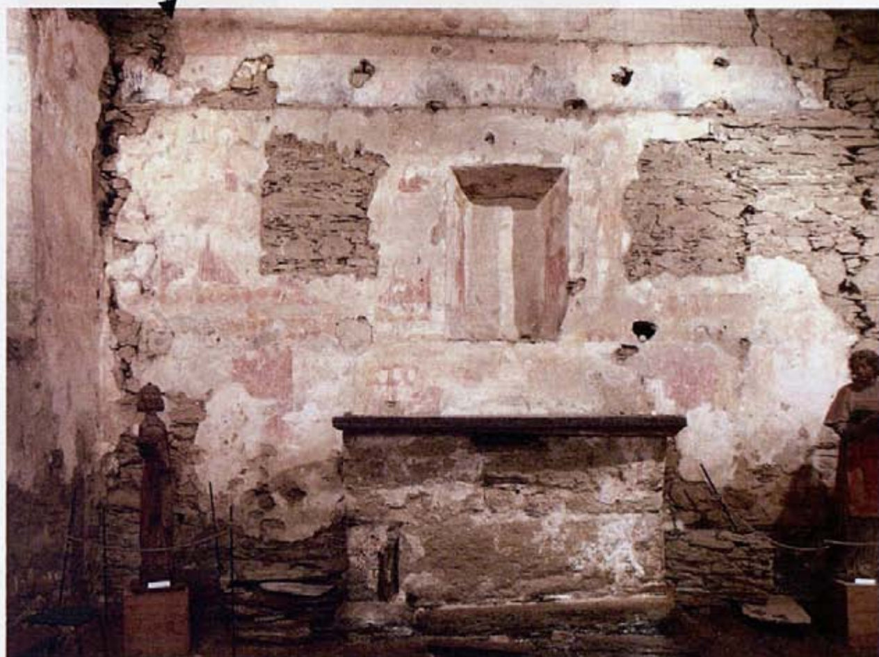
fig. 46 : vue de la face interne du pignon est
