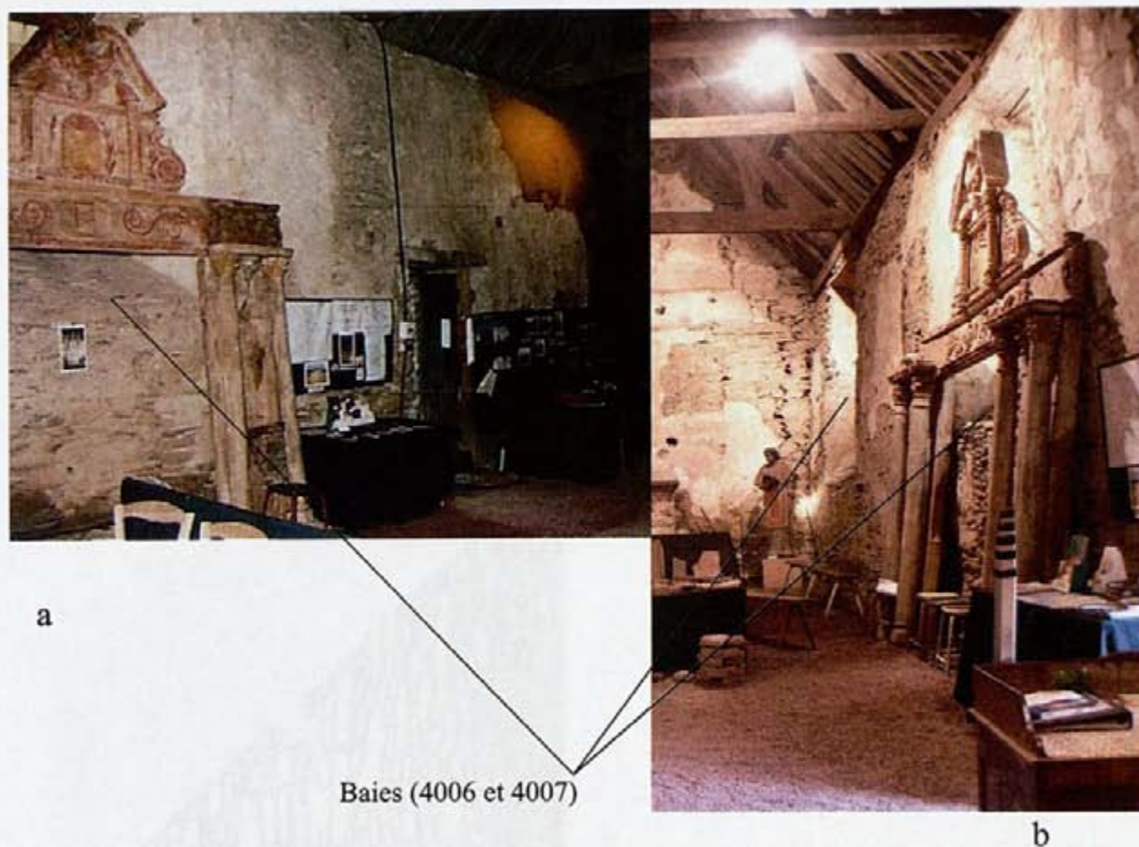
fig. 43 : vue d'est en ouest (a) et vue d'ouest en est (b) de la face interne du mur sud.
