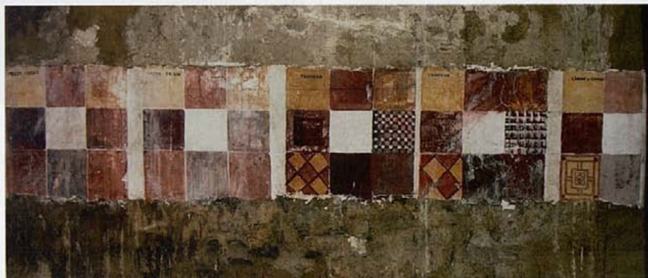
fig.20 : reste des échantillons de confortation des enduits peints du mur nord (cliché : M.Lagneau)
