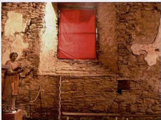
Niche ménagée dans le mur sud
