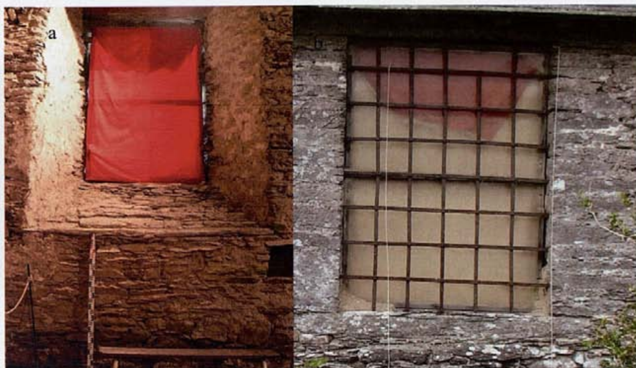
fig.19 : protections mises en place sur les grandes baies des murs sud (a) et nord (b) (clichés Merdy Élise)
