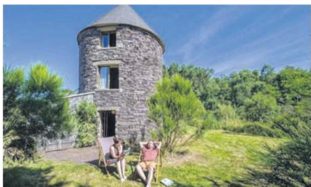
Le moulin de Rohan avant l'incendie. Emmanuel Berthier.
