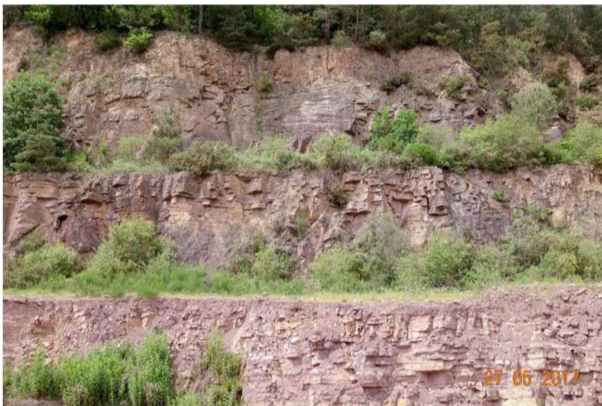
Les bancs gréseux en profondeur sont massifs et sains, proches de la surface ils sont plus délités ( interbancs et fractures ).
