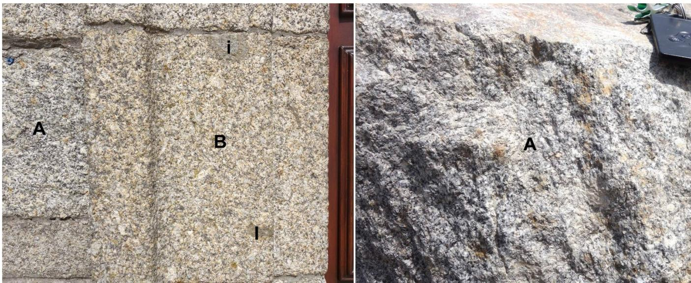
**Illustration 5 :** Granite de Ménéac faciès à gros cristaux (porphyroïde) **Eglise de Ménéac – Entrée Ouest de la carrière.** **A :** montre un granite relativement frais, **B :** un granite plus altéré, **I** représente des inclusions arrachées à l'encaissant briovérien lors de la montée du pluton granitique.
