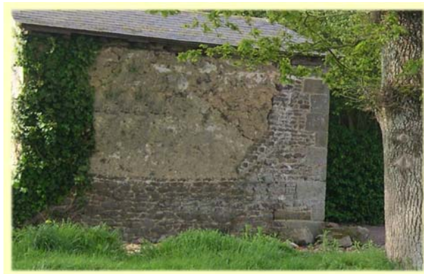
Appareillage de pierres et de terre photographie C. Juhier
