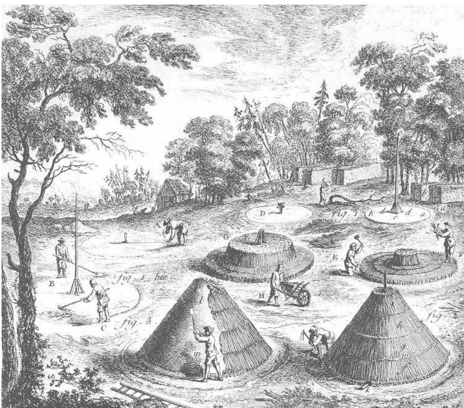
La construction des meules de charbon de bois Encyclopédie, ou dictionnaire raisonné des sciences, des arts et des métiers (1751)
