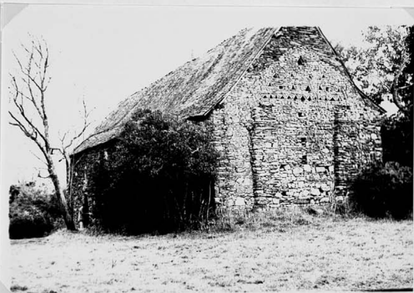
Photo 2 : La chapelle Saint-Etienne. Vue du chevet. On remarque au dessus des contreforts les arcs mitrés, faits de briques romaines, et au niveau du sol les assises de briques.
