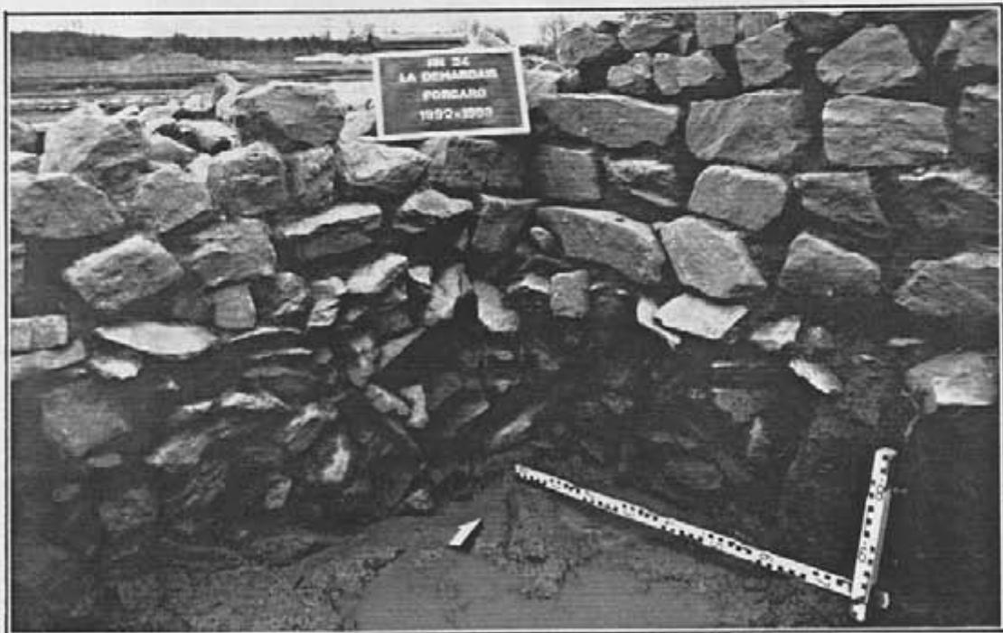
1,2 Détail de construction: parements avec blocage interne et fondation constituée d'un blocage implanté en tranchée.
