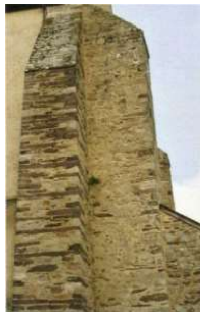
Contrefort (XV ème siècle) : grès quartzite et grandes dalles de schiste pourpre.
