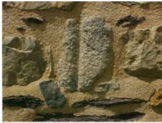
Granité à grain moyen (de Ménéac) en remploi dans le mur de la salle des Écrouettes.
