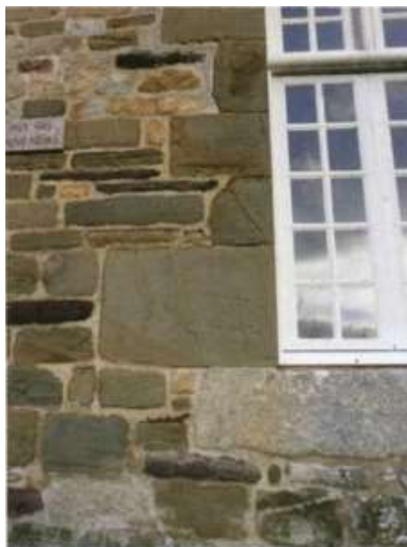
Au XVII ème siècle : apparition du grès briovérien en encadrement d'ouvertures (et parmi les moellons).
