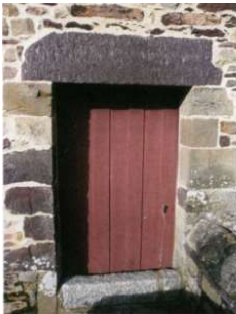
Ancien baptistère (XV ème siècle) - linteau de schiste pourpré posé « à délit » (terme ici incorrect puisque le débit principal se fait suivant la schistosité et non suivant le litage sédimentaire) - les lignes claires verticales sont, ici encore, des skolithes. Le seuil, en granité à grain moyen de Ménéac est de pose très récente.
