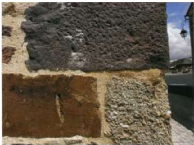
À l'angle, en bas : poudingue de Gourin, en haut : roussard. En bas à gauche : grès quartzite avec pellicule de rouille déposée par les eaux circulant dans les fissures du massif rocheux.
