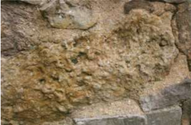
Grès « ordinaire » en moellon informe, riche en tubes de vers fossiles (skolithes). Au dessous : bloc anguleux de grès quartzite.
