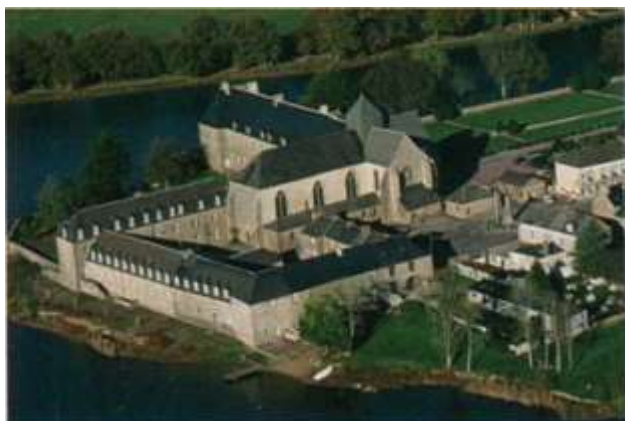
Détail d'une vue aérienne (photo Maurice Gautier).
