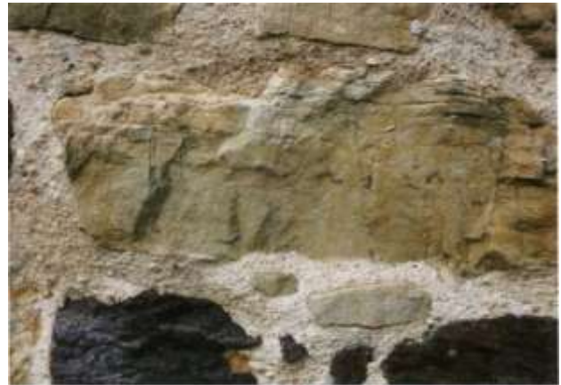
Grès quartzite : moellon sur lequel sont visibles . - le litage sédimentaire (horizontal), - les tubes de vers fossiles (verticaux).
