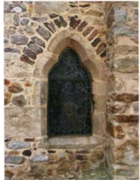
Petite ouverture de l'ancien baptistère : entourage de blocs de volcanites. - le bloc bas gauche dont les dimensions sont démesurées par rapport à celles de l'ouverture témoigne d'un remploi, - bel arc de décharge en schiste pourpré.
