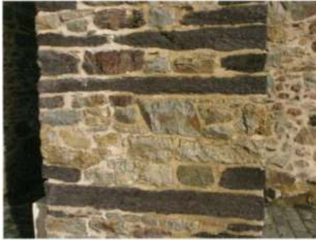
Contrefort : grandes dalles de schiste pourpré et moellons de quartzite - certains de ces moellons présentent des cassures esquilleuses dues à quelques coups de marteau pour supprimer les angles trop saillants.
